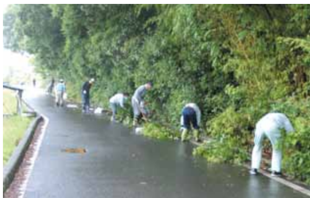
道路にはみ出した枝の伐採・草刈り・側溝内の土砂出しなど大変な作業でした。
